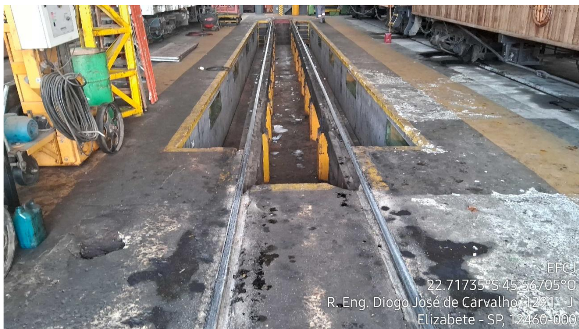
Figura 28 - Manchas de óleo em piso com trincas e no interior da vala de manutenção - Pátio de Manutenção Capivari
