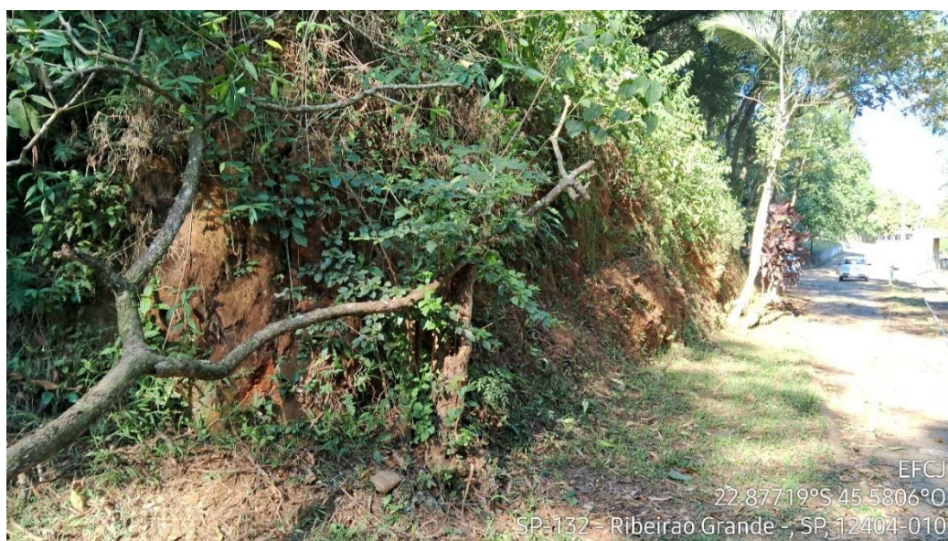
Figura 43 - Erosão laminar e rolamento de blocos em talude - Entrada do Parque Reino das Águas Claras
