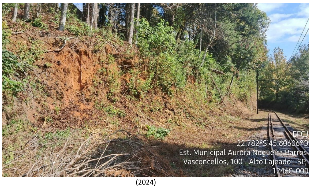
Figura 75 - Erosão laminar e árvores inclinadas e com raízes expostas - Lajeado
