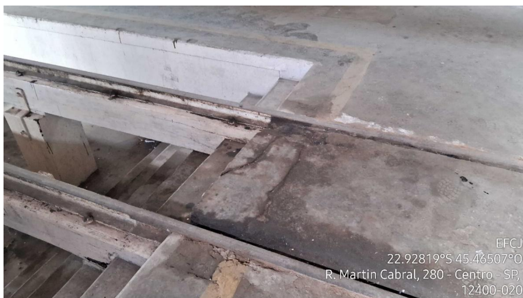
Figura 1 - Manchas de óleo em piso com fraturas - Pátio de Manutenção de
