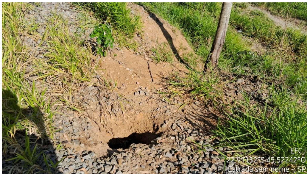
Figura 34 - Erosão laminar à jusante da via permanente
