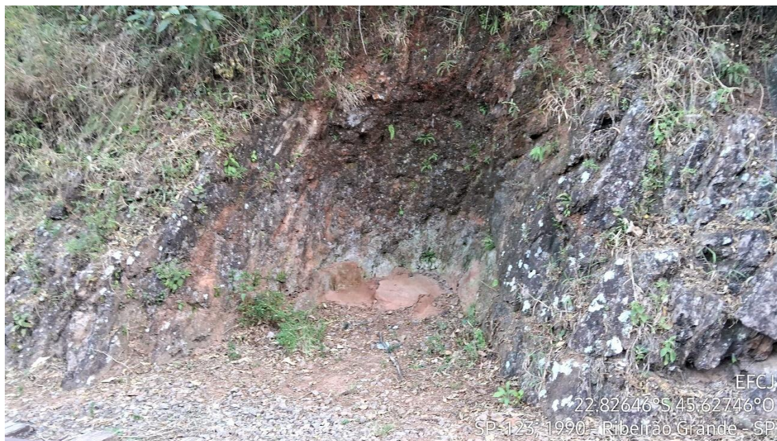
Figura 57 - Processo de erosão em rocha em talude em proximidade com a via - Mirante de Nossa Senhora Auxiliadora
