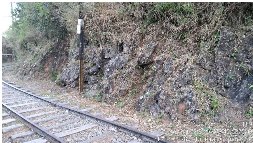
Figura 57 - Processo de erosão em rocha em talude em proximidade com a via - Mirante de Nossa Senhora Auxiliadora
