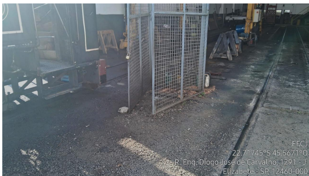
Figura 30 - Manchas de óleo por sobre a brita e piso com trincas na entrada do pátio - Pátio de Manutenção Capivari
