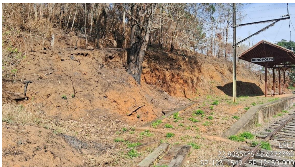
Figura 59 - Talude com processos erosivos intensos - Parada Renópolis
