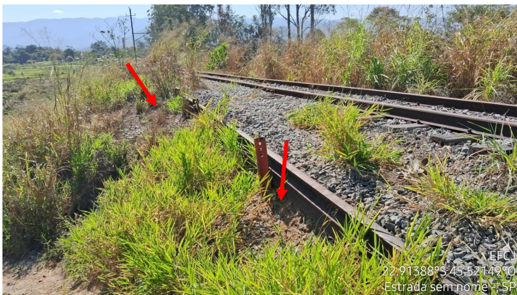
Figura 32 - Contenção de leito da ferrovia com a utilização de trilhos
