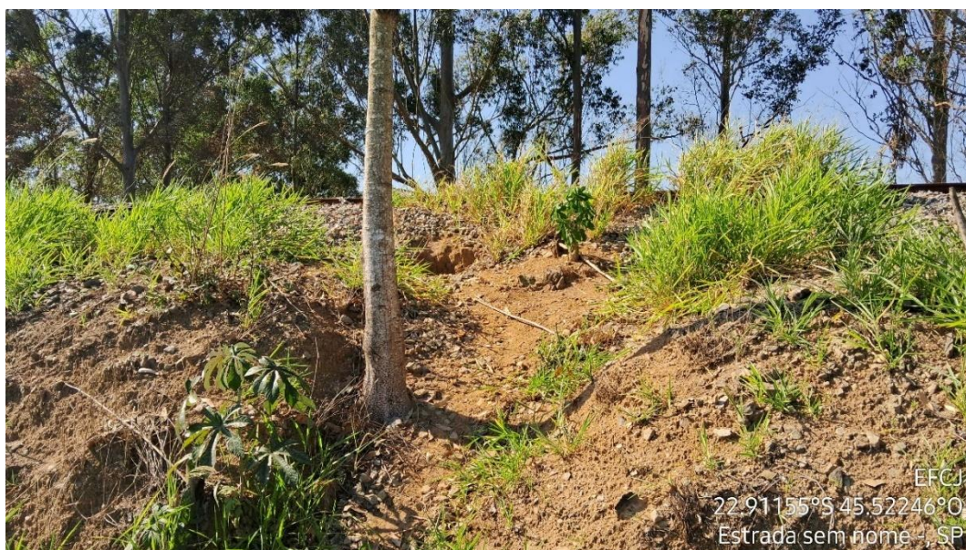
Figura 35 - Erosão laminar à jusante da via permanente
