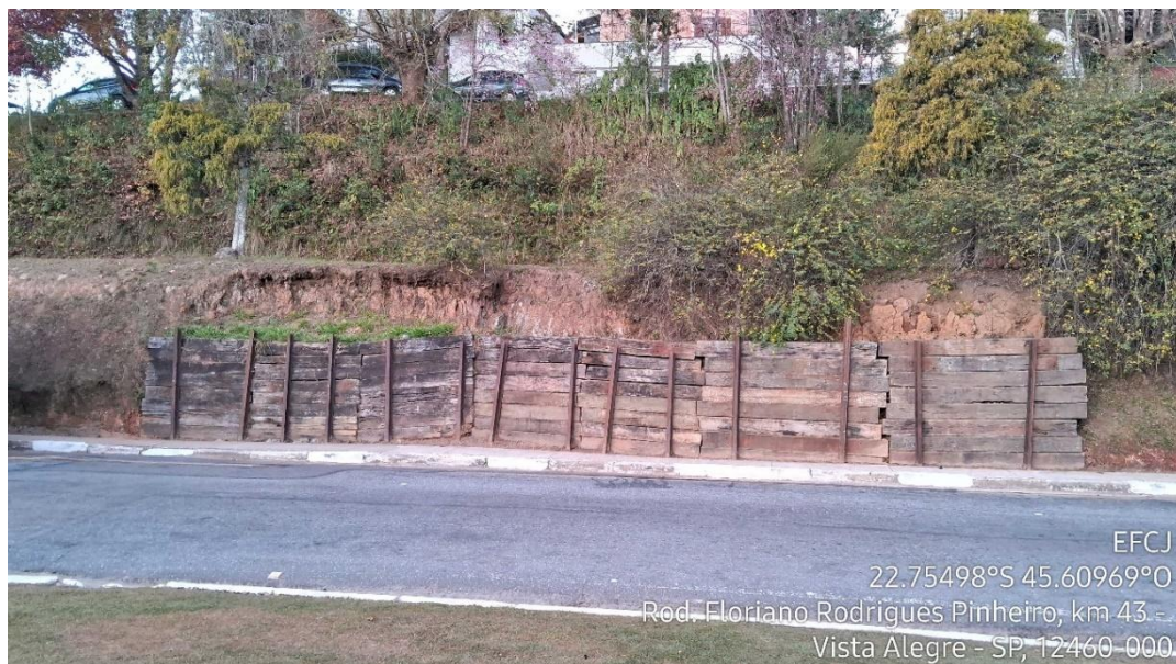
Figura 77 - Contenção improvisada com trilhos e dormentes
