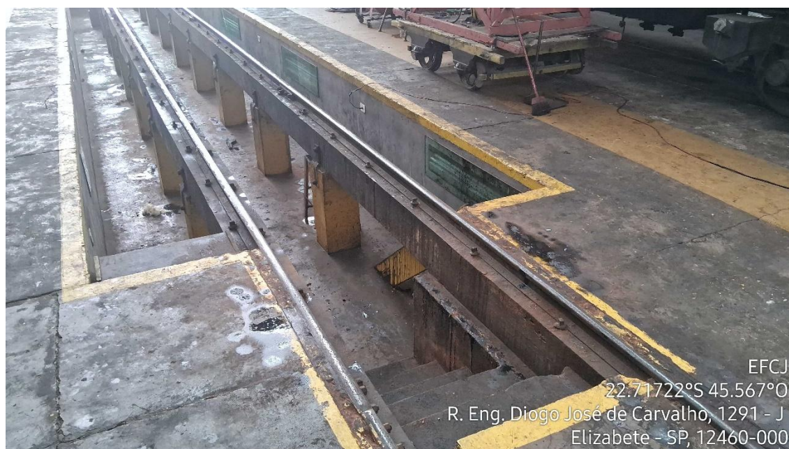
Figura 26 - Manchas de óleo por sobre o piso com trincas próximo à vala de manutenção - Pátio de Manutenção Capivari
